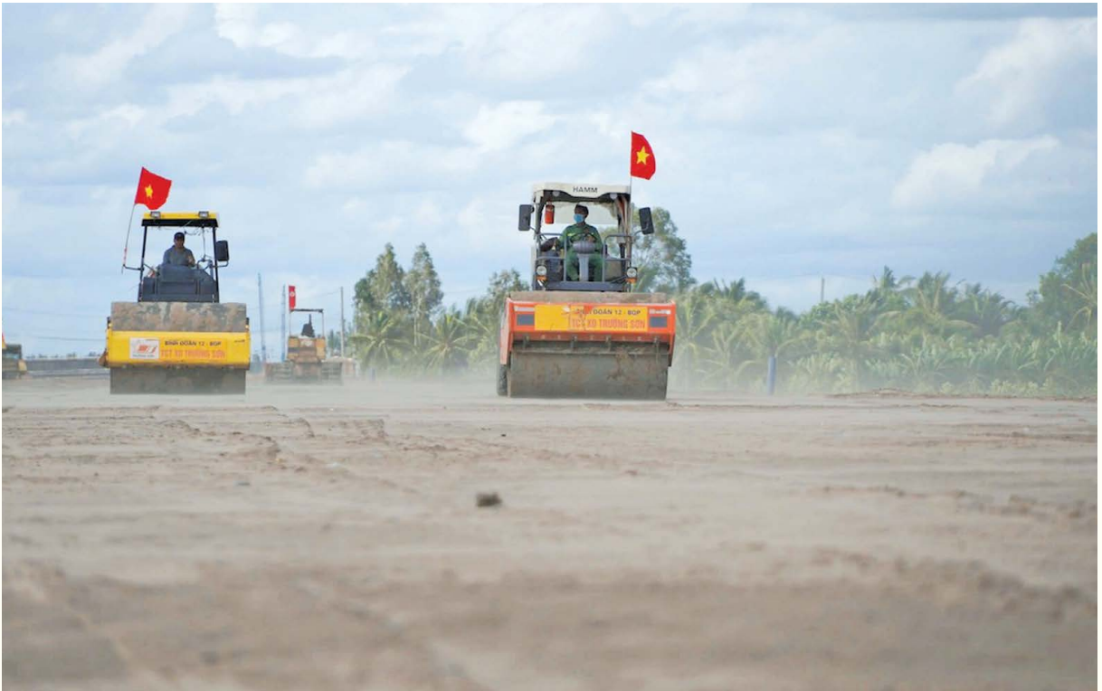
Ngoài các dự án cao tốc, ĐBSCL còn cần cát cho các dự án hạ tầng khác. Trong ảnh là cao tốc Cần Thơ - Cà Mau đoạn qua tỉnh Hậu Giang. Ảnh: Trung Chánh
